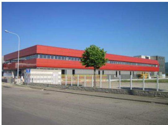
Figura 5: Immagine esterna del Datacenter
