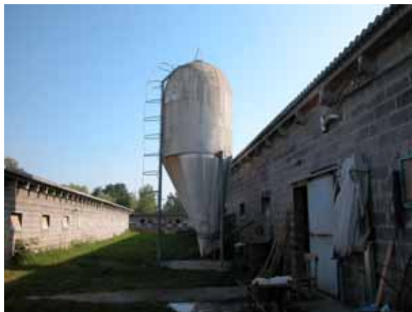
Figura 1 – Silo in vetroresina spesso non adeguatamente ancorato al suolo.
