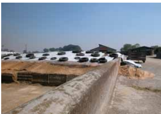
Figura 3 – Silo a trincea parzialmente interrato rispetto al piano di campagna.
