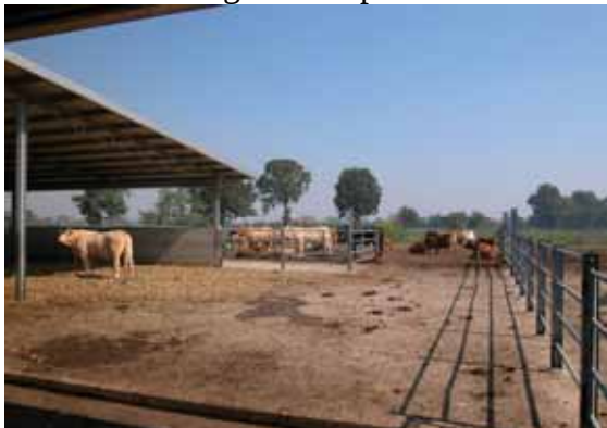
Figura 2 - Ricovero a stabulazione libera con area coperta a lettiera e area scoperta pavimentata.
