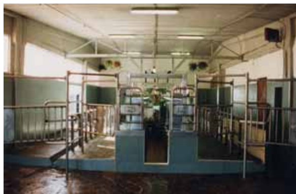
Figura 2 – Pavimento reso antiscivolo mediante l'uso del porfido.
