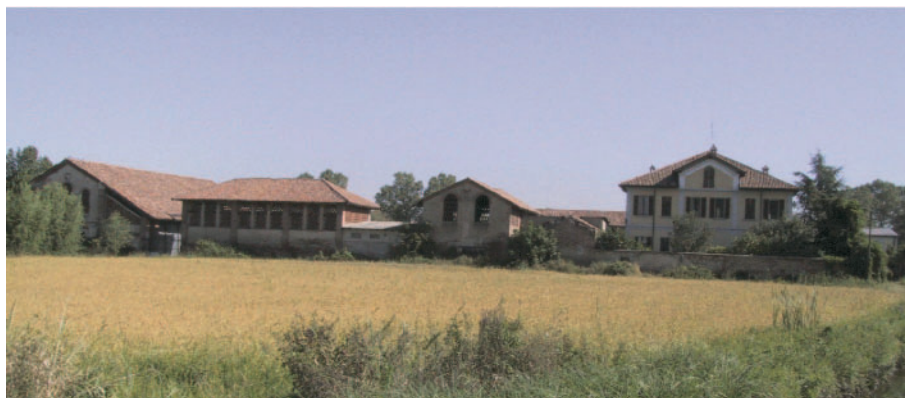
Insediamenti agricoli di incidenza paesistica (archivio PIM)
