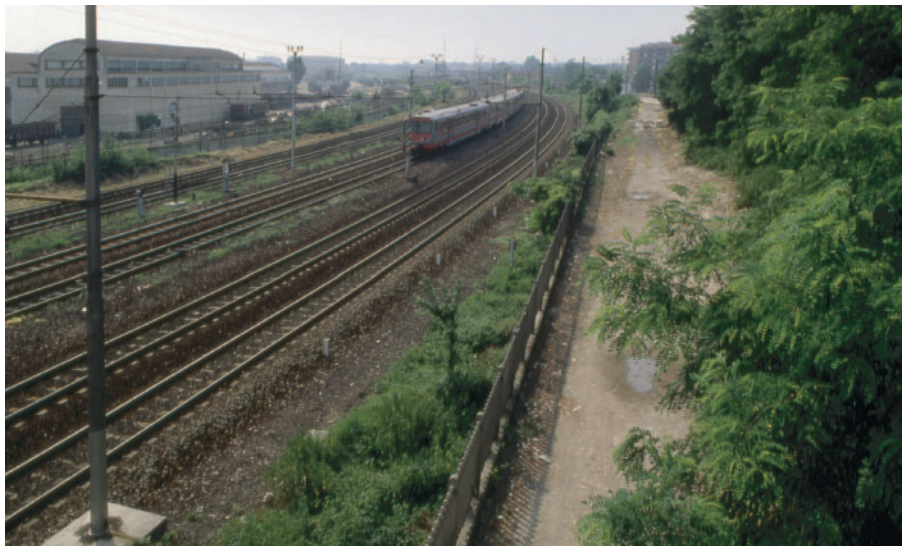
Lo Scalo di San Cristoforo
